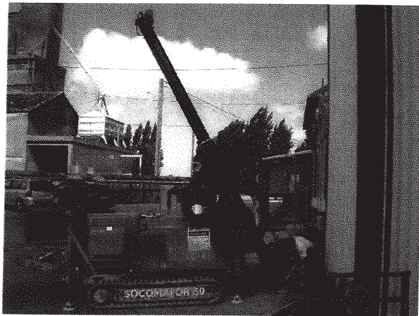
S2 : Station d'épuration
